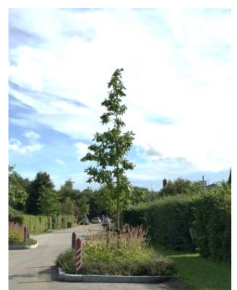
Plantehul gjort større så det tager en del vejareal. Her fungerer det både som trafikløsning og plantebed for træet.
