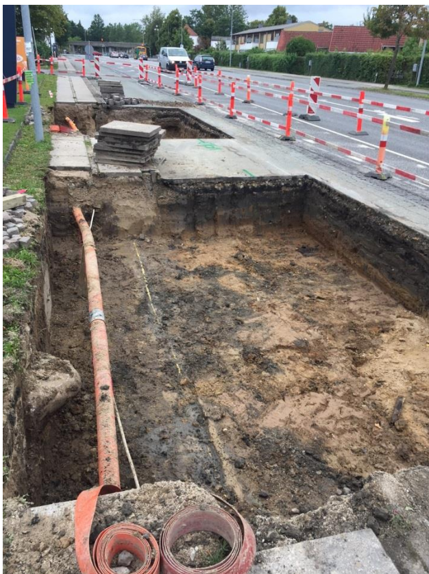
Her ses en opgravning, klar til at få anlagt rødvenligt bærelag. Løsningen sikrer både trafik for gående og cyklister, samtidig med at træernes rødder får et større vækstmedie til rådighed.
